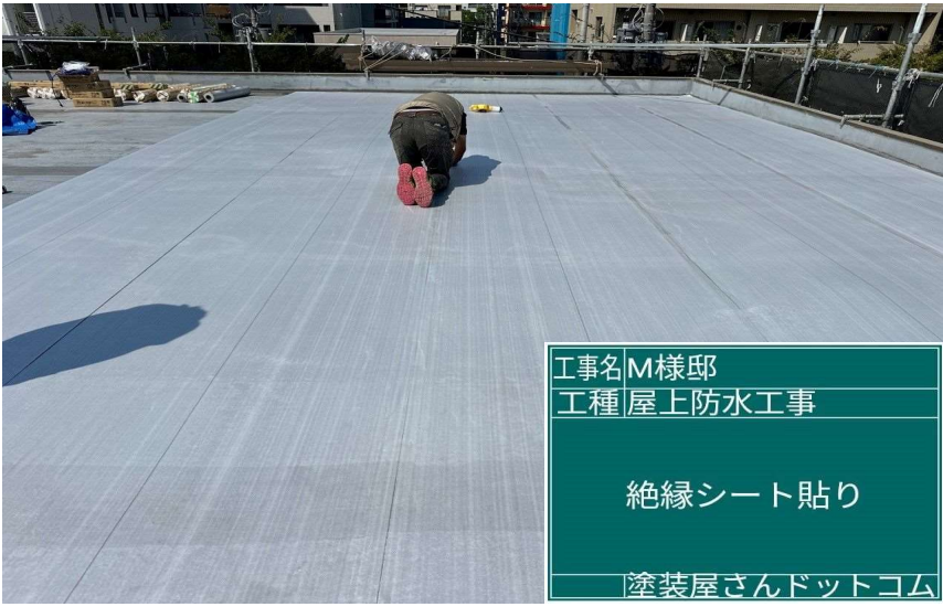
工事名 M様邸 工種 屋上防水工事 絶縁シート貼り 塗装屋さんドットコム
