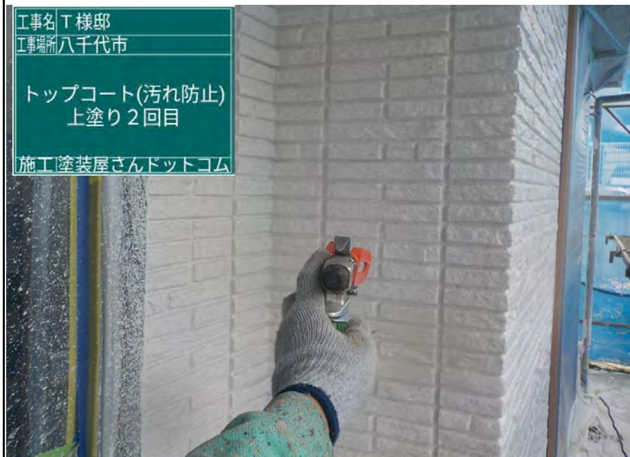
外壁 (上塗り2回目) ※トップコート仕上げ
