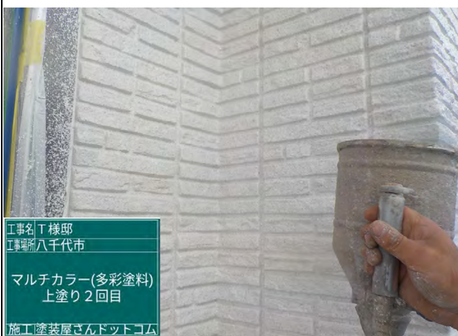
工事名 T様邸 工事場所 八千代市 マルチカラー(多彩塗料) 上塗り1回目 施工 塗装屋さんドットコム
